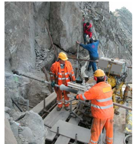
Bohrarbeiten im Permafrost Fels zur Überwachung von Temperatur und Deformationen
